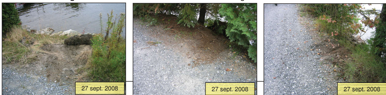
Figure 24 : Canaux d'écoulement creusés le long du chemin Paradis
