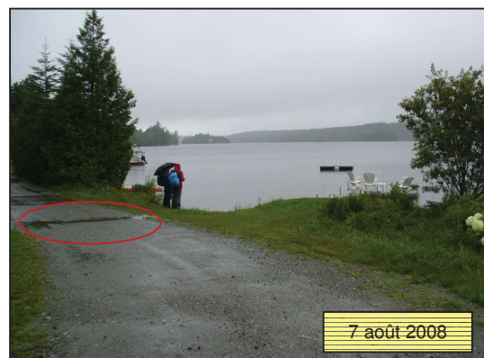
Figure 24 : Canaux d'écoulement creusés le long du chemin Paradis
